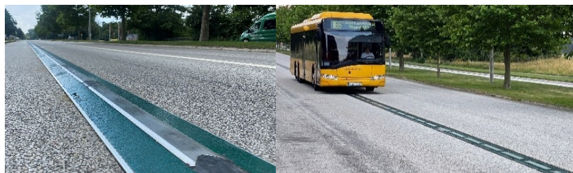
Figur 3.9 Elonroads upphöjda respektive nedsänkta skena
